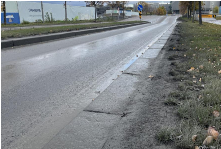
Figur 7 De tilfellene hvor det har blitt brukt vanning ved anlegget, har det blitt store avrenninger og gjørme i veien. Bildet viser John Strandrudsvei som anlegget krysser, som er hovedinnkjørselsvei for sykehjemmet, flere boligområder, og vei til barnehager og skoler.
